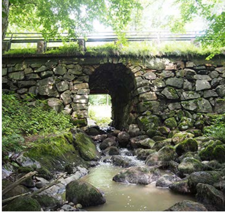
Kuva 83. Espoon Espoonkartanon Sägbron vuonna 1777 valmistunut kiviholvisilta on Suomen vanhin yhä tieliikennekäytössä oleva silta. Museosilta sijaitsee valtakunnallisesti merkittävässä kulttuuriympäristössä (RKY-alueet Espoon-kartano ja Suuri Rantatie). Kuva: Teemu Mökkönen 2024, KY530:2, Museovirasto.
