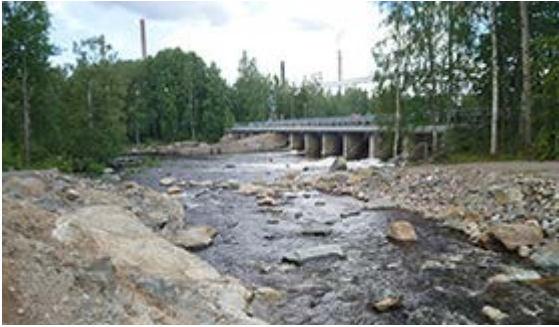
Kuva 51. Varkauden Ämmäkosken säännöstelypadolle valmistui Suomen suurin luonnonmukainen ohitusuoma vuoden 2022 lopulla. Se toteutettiin osana NOUSU-ohjelmaa yhteistyössä WWF:n Vauhtia vaelukseen-hankkeen kanssa. Toteutuksessa oli mukana säätiöpohjaista rahoitusta. Kuvissa ohitusuoman alku padon yläpuolella (vas. ylh.), uoman keskikohdasta ja uoman loppupää padon alapuolella. Kuvat: Teemu Mökkönen 2023, KY532:1-3, Museovirasto.
