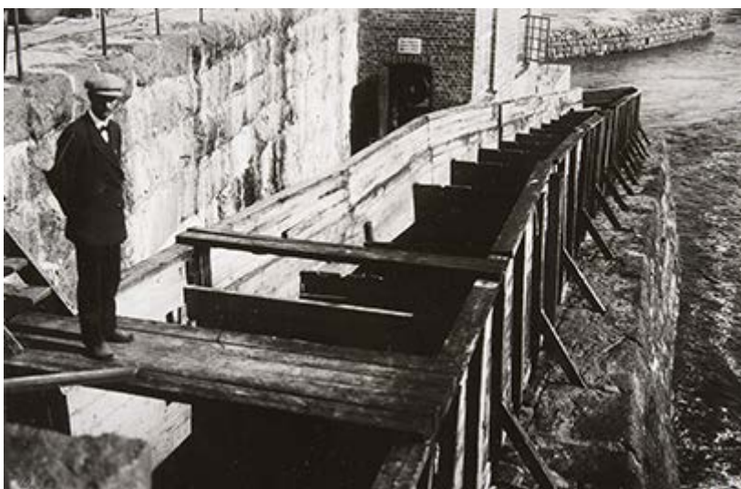
Kuva 50. Puinen kalaporras Stockforsin tehtaan vieressä Kymijoen Pyhtään haarassa. Huoli vaelluskaloista tiedostettiin hyvin jo 1800-luvun lopulla (Reuter 1893), mutta varhaiset kalatiet toimivat usein heikosti. Kuva: T. H. Järvi 1920, KK2969:626, Museovirasto.
