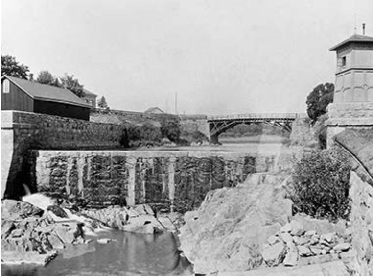
Kuva 35. Helsingin Vanhankaupunginkosken kivipato Vantaanjoen läntisessä suuhaarassa valmistui 1870-luvulla Helsingin vesihuollon tarpeisiin. Kiilakivistä tehty holvipato edustaa insinööritieteiden nousun myötä kehitettyä ja Suomessa harvinaista patotyyppiä. Kuva: tuntematon kuvaaja 1890-luku, Helsingin Kaupunginmuseo, N182100. CC BY 4.0.
