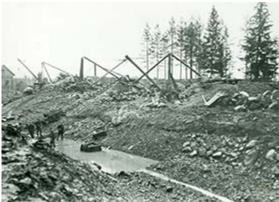
Kuva 40. Sammaljoen Kaunistonkosken perkaustyömaa Vammalan (ent. Tyrvään) Illolassa vuosina 1925–1926. Sammaljoki on Kokemäenjoen sivujoki, jonka perkaukset on tehty pääosin tulvien hallintaa ja peltojen kuivatusta varten, vaikka jokea on käytetty myös tukinuittoon. Kuvat: tuntematon kuvaaja, Sastamalan seudun museo. Yläriivi: 1:126a ja 1:1726e, alariivi: 1:1726q ja 1:17126d. CC BY-NC-ND 4.0.
