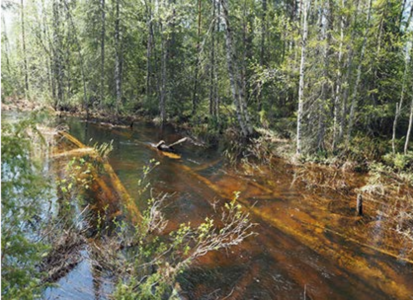
Kuva 79. Tengeliönjoen vesistön Alposjoen säästöpaton säilyneitä puurakenteita uittoaукolta alavirtaan päin. 1970-luvulla toteutetussa joen kunnostuksessa rakenteiden purkamista ei katsottu aiheelliseksi. Alposjoen uittolaitteiden jäänteet on rakennettu 1920- ja 1930-luvuilla. Kohde: Pello Ylinen Alposjoki Välikoki 1. Kuva: Teemu Mökkönen 2024, AKDG7436:5. Museovirasto.
