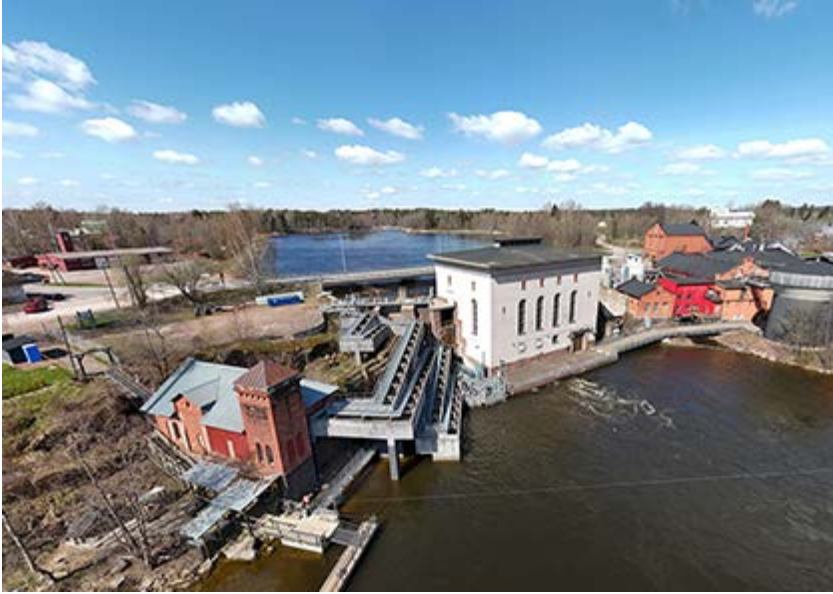
Kuva 78. Kymijoella Kotkan Korkeakosken vesiputouksella on 1500-luvulta alkaen sijainnut vesivoimaa käyttänyttä teollisuutta. Nykyinen pato ja rakennuskanta ovat 1800- ja 1900-lukujen taitteesta (RKY-alue Korkeakosken teollisuusympäristö). Patoa yli johdettava betoninen tekninen kalatie valmistui vuonna 2016. Ennen nykyistä patoa kosken pudotuskorkeus oli noin 8 metriä. Putous muodostui kaloille luontaiseksi vaelukseksi joiesihistoriallisena aikana. Kuva: Teemu Mökkönen 2024, KY525:1, Museovirasto.
